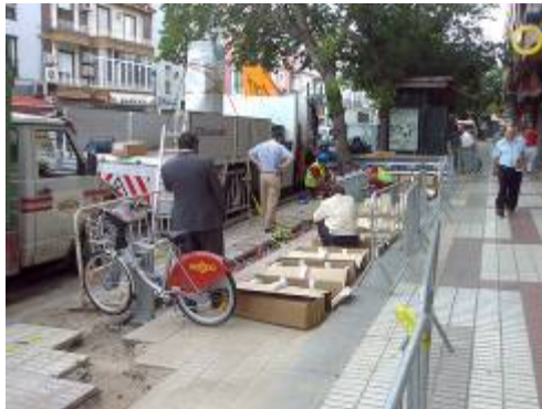
Instalación de una estación de Ciclocity en Sevilla
